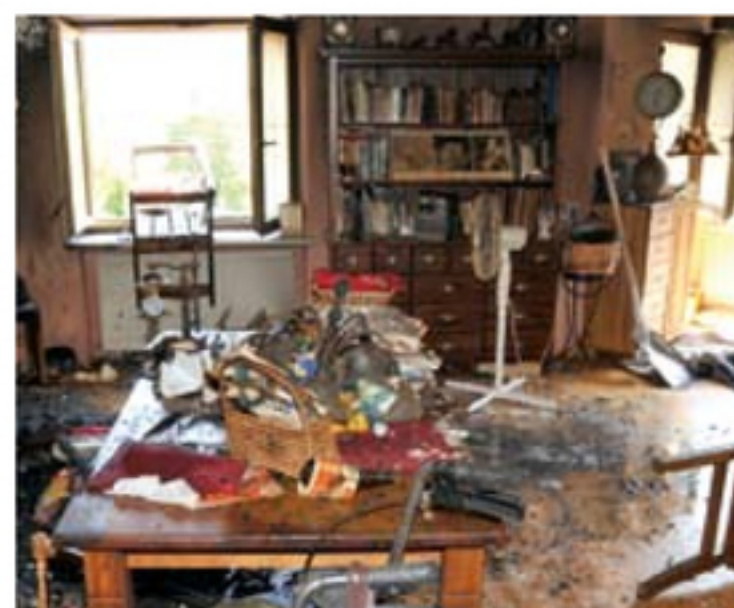
Wohnungsbrand: Als Brandursache kommt unsachgemäßer Umgang mit Kerzen oder Rauchwaren in Betracht.
