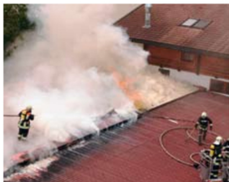
Starke Rauchentwicklung: Alle Arbeiten mussten mit Atemschutzgeräten durchgeführt werden.
