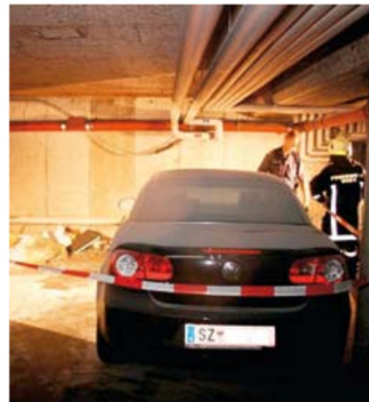
Tiefgarage: Mehrere Gegenstände gerieten in Brand, ein Auto wurde beschädigt.
