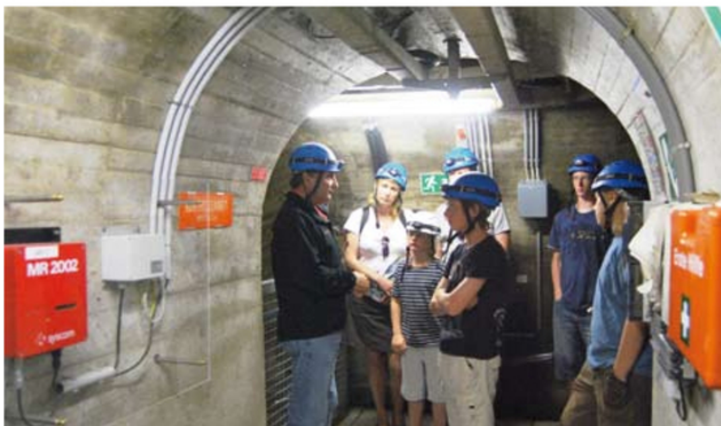
Technik erleben: Staumauerführer Franz erklärt Interessierten mit viel Geduld das Innenleben der Staumauer Schlegeis.
