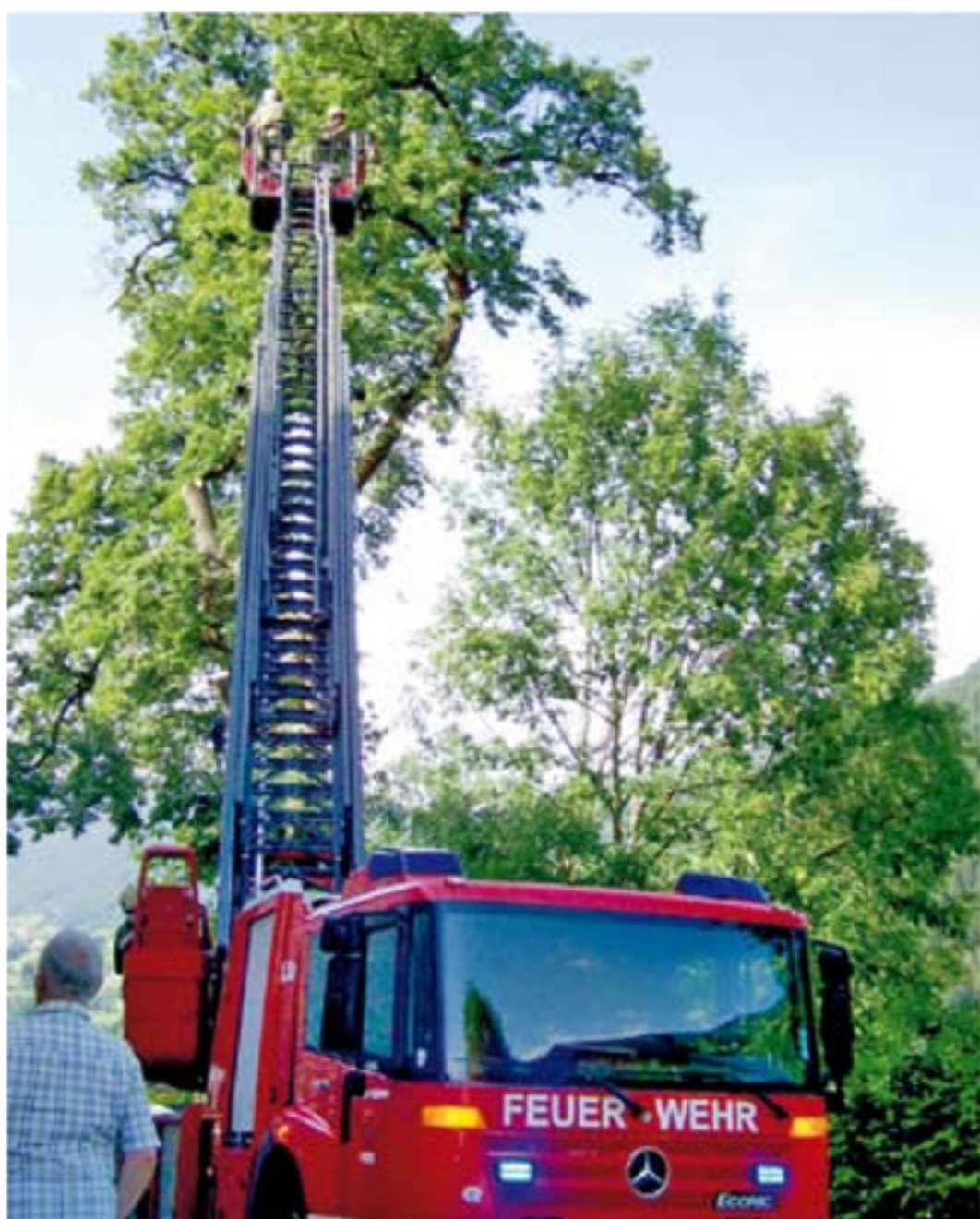
Ein schwerer Sturm wütete im Zillertal – die 160 Jahre alte, unter Naturschutz stehende Linde neben der Kirche in Aschau wurde so stark beschädigt, dass man sich zum Fällen des Baumes entschied. Die Drehleiter aus Fügen und das schwere Rüstfahrzeug aus Mayrhofen wurden angefordert – die Feuerwehrmänner standen viele Stunden im Einsatz!
