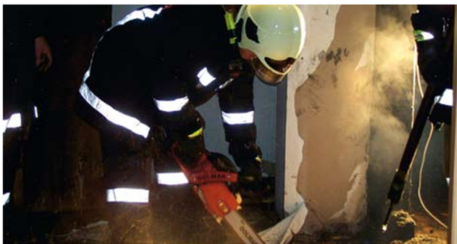
Große Teile der Wand zwischen Kamin und Ofen mussten abgetragen werden.
