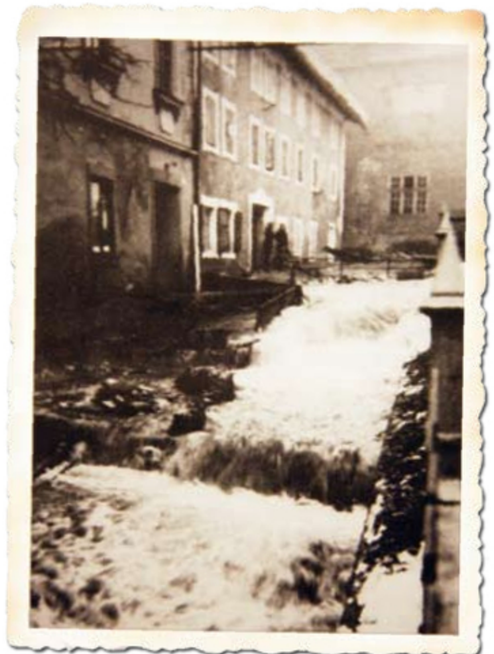
Der Wurmbach bahnte sich ein neues Bett durch die Straßen!
