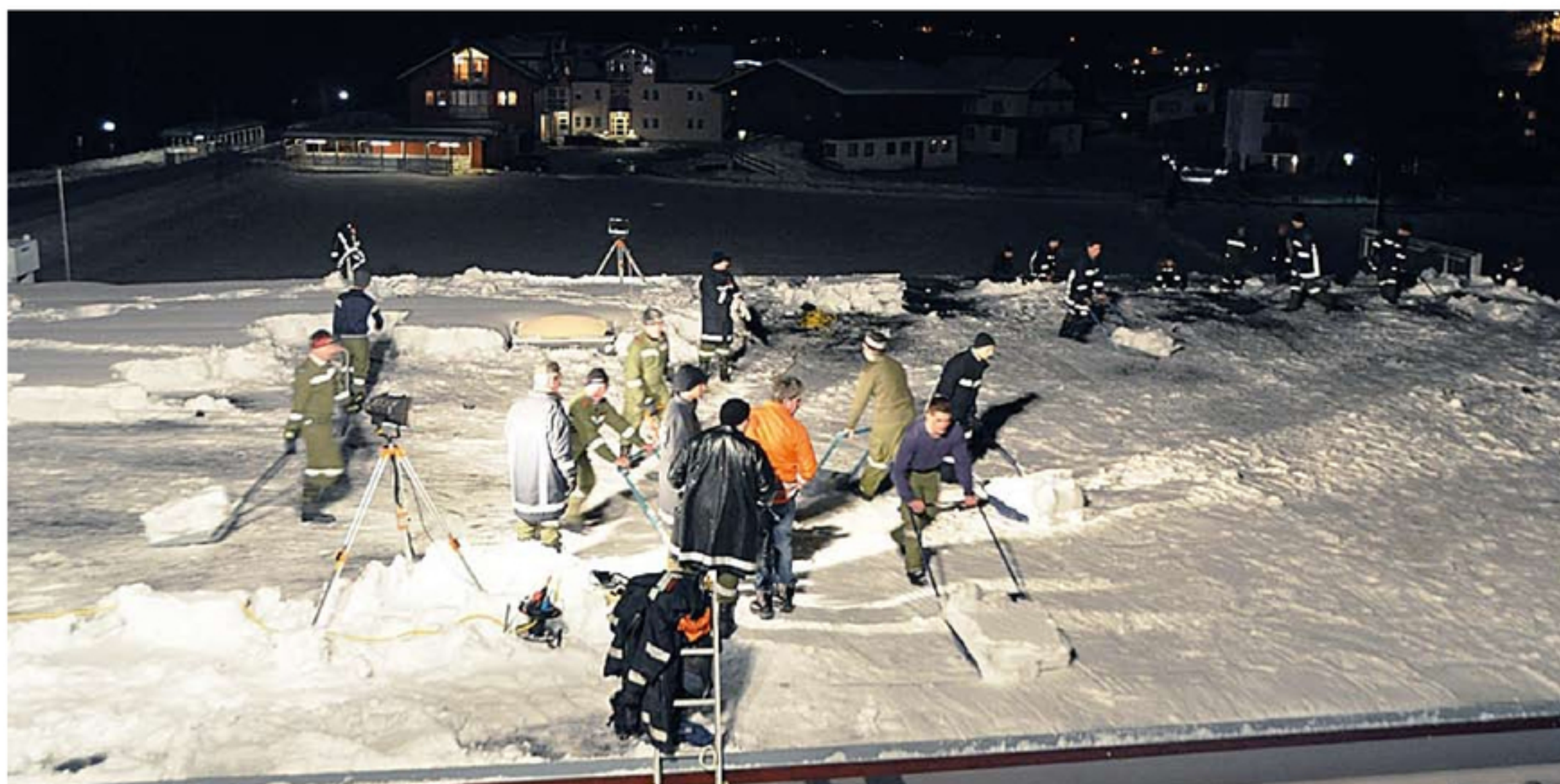
Das großflächige Dach des SPAR-Marktes in Zell am Ziller musste in einem Großeinsatz von den Schneemassen befreit werden.
