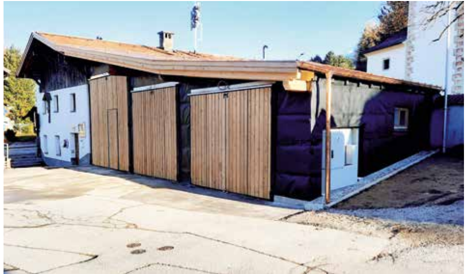
Die Anhebung des Dachs und der Zubau einer dritten Box bietet der Feuerwehr Vill neue Möglichkeiten für die Unterbringung der Fahrzeuge.
