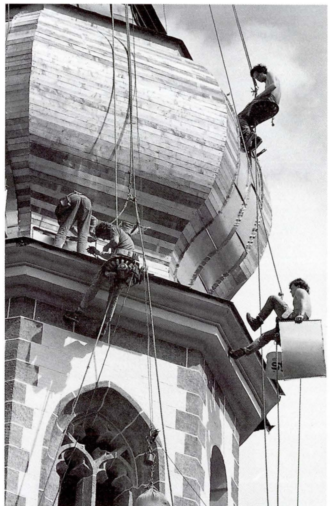
Neuverschalung und Eindeckung der Turm-Kuppen, 1989
