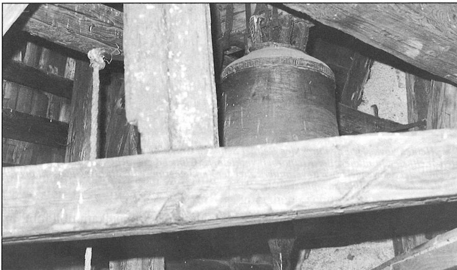
Die sogenannte „Heidenglocke“ ist durch vier nachschraubbare Eisenbänder an einem Glockenjoch befestigt und in gewöhnlichen Zapfen gelagert. Die bis 1992 nicht entzifferte Umschrift sieht man im obersten Bereich des Glockenmantels.
