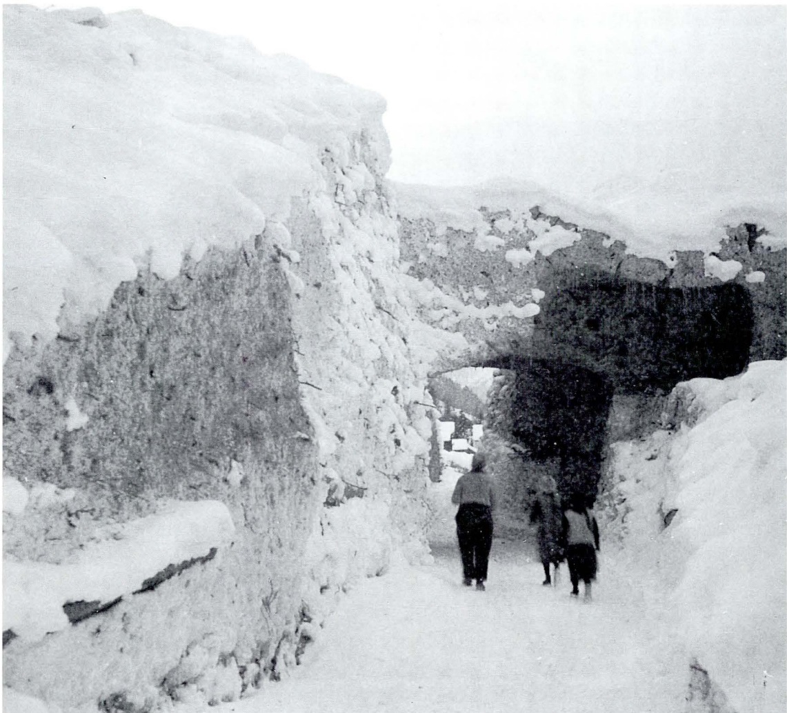
Ein Tunnel durch die Lawine - die Flungtobel-Lawine bei See im Winter 1935. (Foto aus der Schulchronik Holdernach, Gemeinde Kappl)
