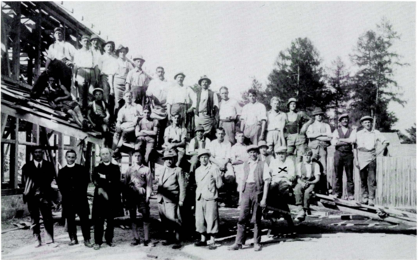
Bau des Erholungsheimes Haiming 1934: Die Arbeiter und die Bauleitung; in Uniform ein Reichsbundführer, ( x Hermann Raffl)
