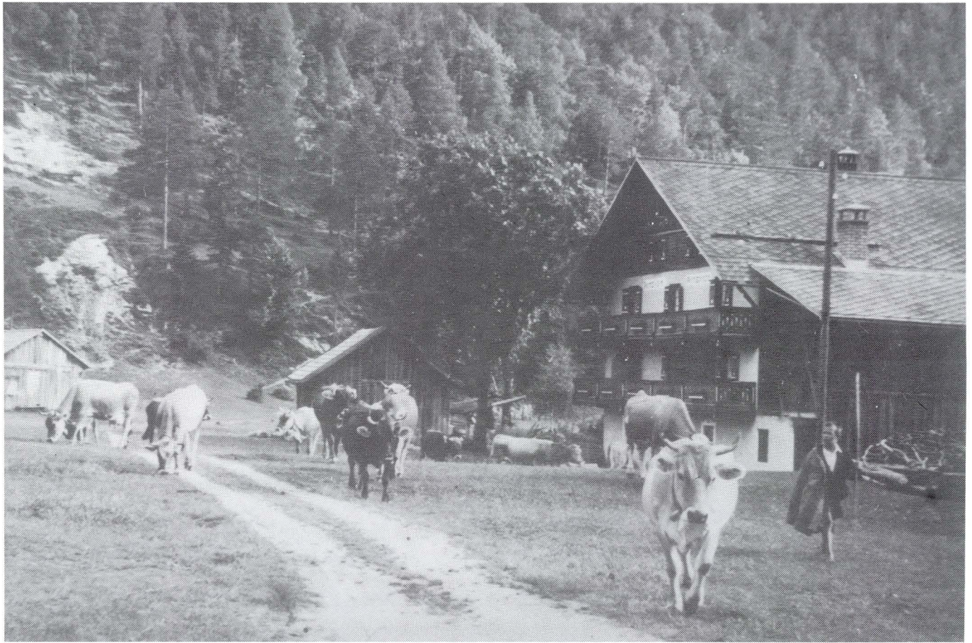
Allabendlicher Abtrieb der Heimkühe im Ortsteil "Eisack" durch den kleinen Hirten.
