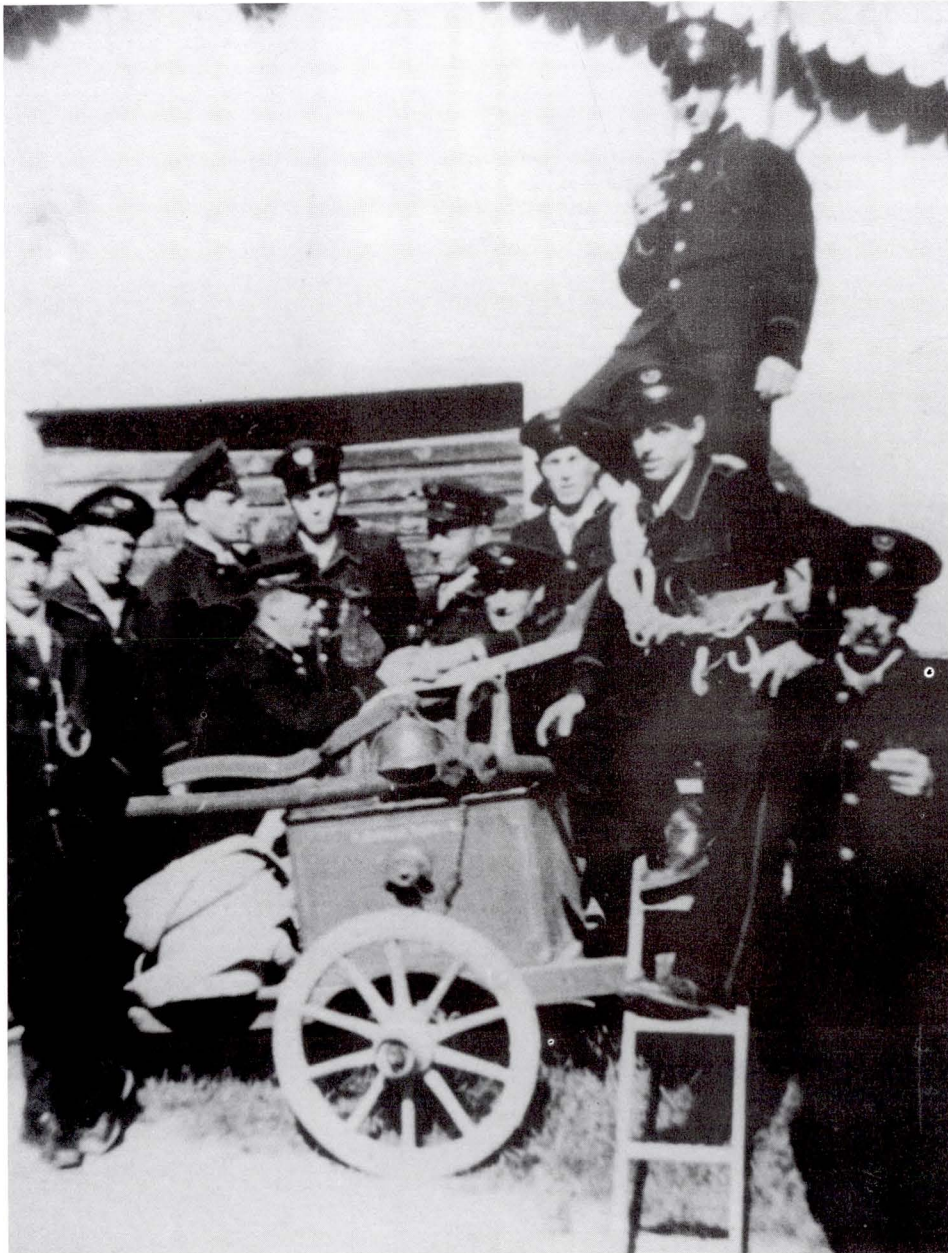
Die handbetriebene Pumpe (Baujahr 1899) der Freiwilligen Feuerwehr Kurtatsch wurde noch in den 30er Jahren eingesetzt
