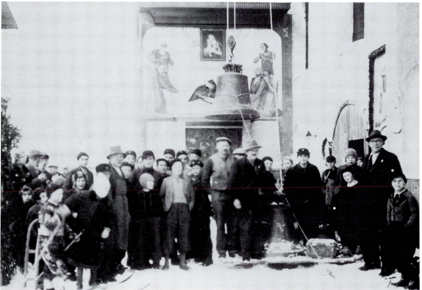
Abnahme der Glocken in Inzing, Februar 1942
