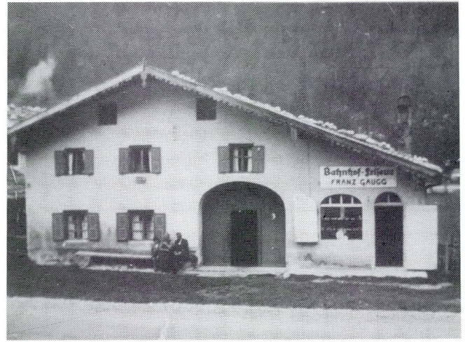
Ursprüngliches Seitenflurhaus mit Einfallsstor und eingelassener Gektüre. Nordseitiger Anbau für das Friseurgeschäft
