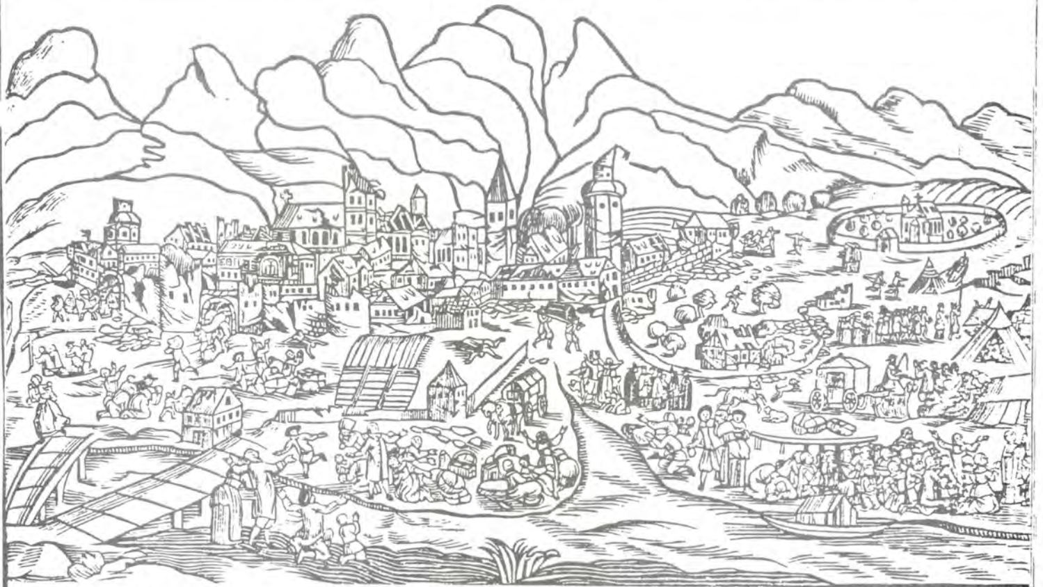
Hall nach dem Erdbeben 1670: Neben vielen Häusern ist der Pfarrturm eingestürzt und die Kirche beschädigt worden.
